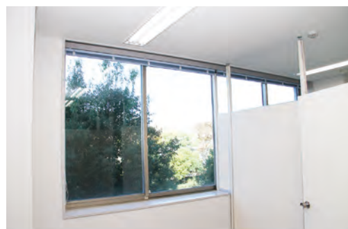
消防法により上部は開いています。
